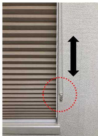
付属の固定ビスでコードフックを固定します。操作できるか確認します。
